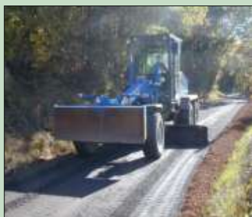
La niveleuse en action sur les travaux de voirie à Mayrinhac-Lentour
